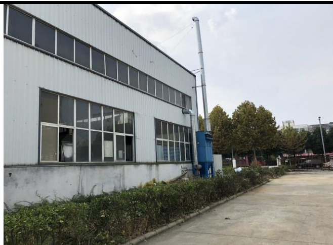
熔化+生物质废气排气筒+除尘器
