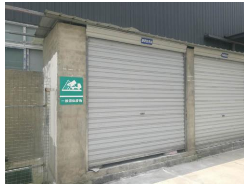
一般固废暂存间
